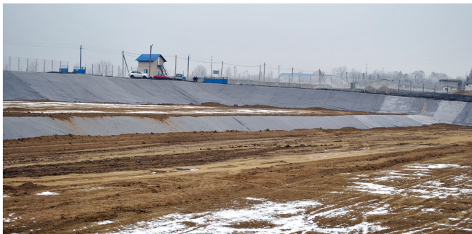
Poligon pentru depozitarea deșeurilor menajere solide din orașul Nisporeni
