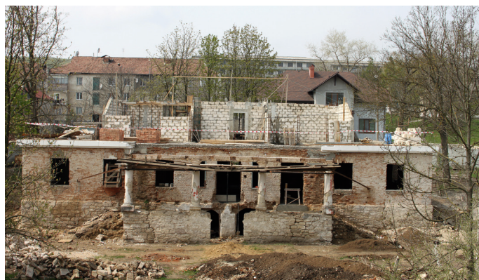
Lucrări de restaurare a Conacului Manuc - Bey
